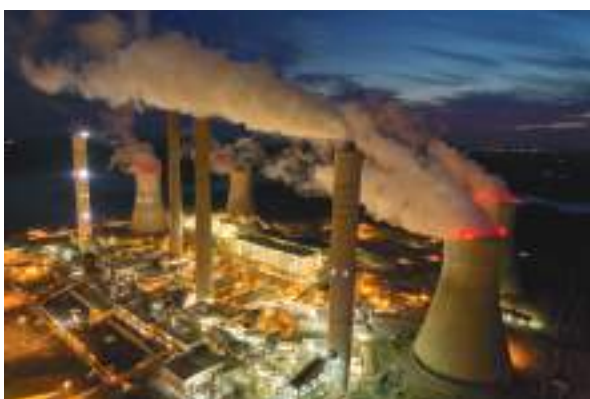
Εργοστάσιο παραγωγής ηλεκτρισμού
