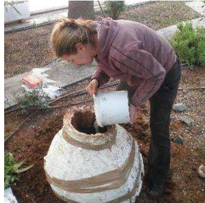
Χύσιμο μπετόν μέσα στο καλούπι
