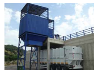
Εικόνα 32. Σταθμός μεταφόρτωσης απορριμμάτων (Πηγή: http://www.argolikesidhseis.gr ).
