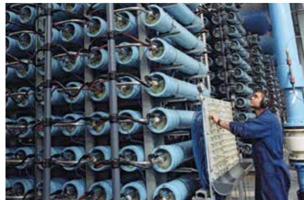
Άποψη του εσωτερικού μιας μονάδας αφαλάτωσης
