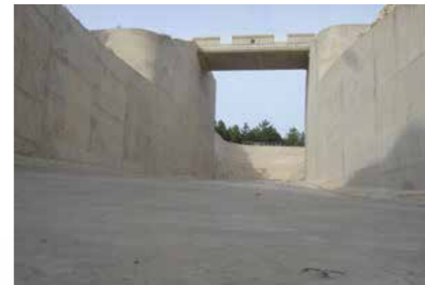
Αγωγός υπερχειλίσης, Φράγμα Ασπρόκρεμμο Πάφου © TomasNY, wikimedia commons
