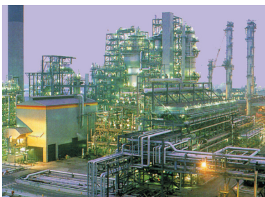
Εγκαταστάσεις πυρόλυσης αλκανίων.
