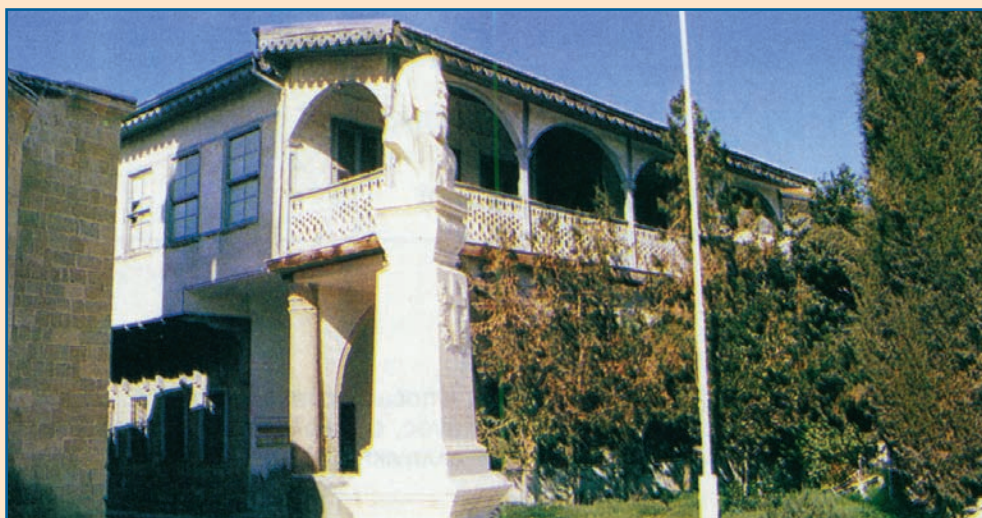
Το παλαιό κτίριο της Ιεράς Αρχιεπισκοπής. Σύμβολο εθνικών και θρησκευτικών αγώνων.
