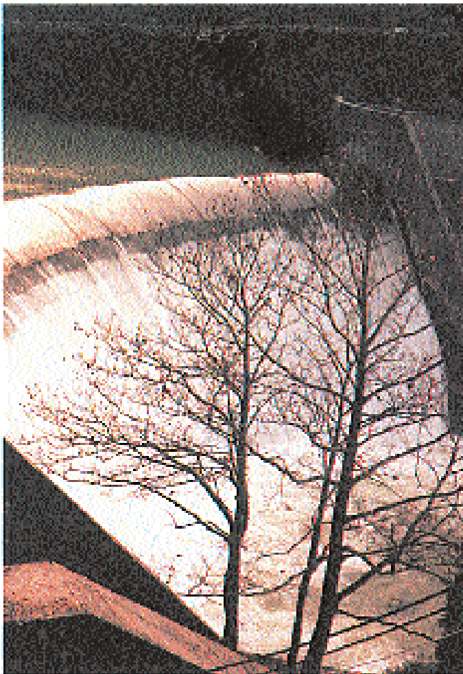
Υδροηλεκτρικό φράγμα: Υδροηλεκτρική ενέργεια
